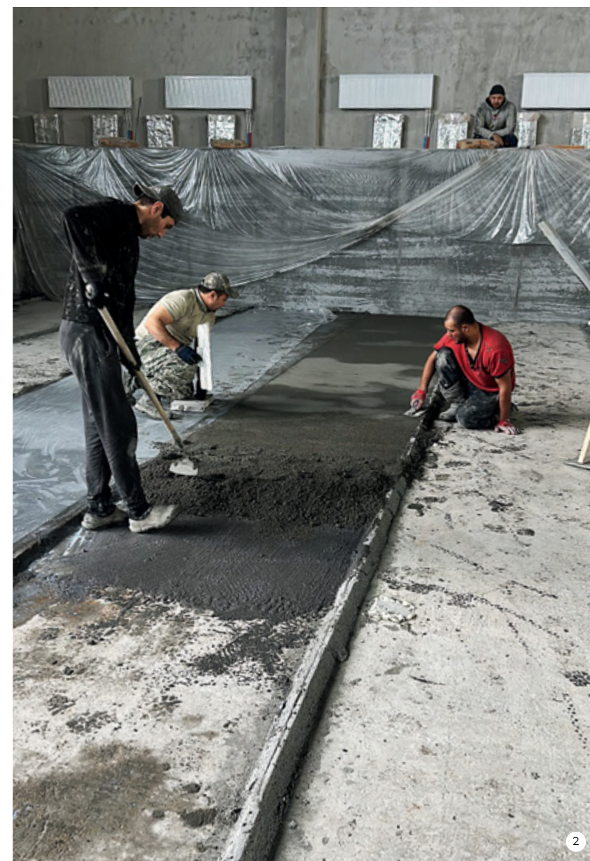
1-4. Для выравнивания чаш бассейнов применялись Nivoplan Plus (Нивоплан Плюс) и Topcem Pronto (Топчем Пронто).
